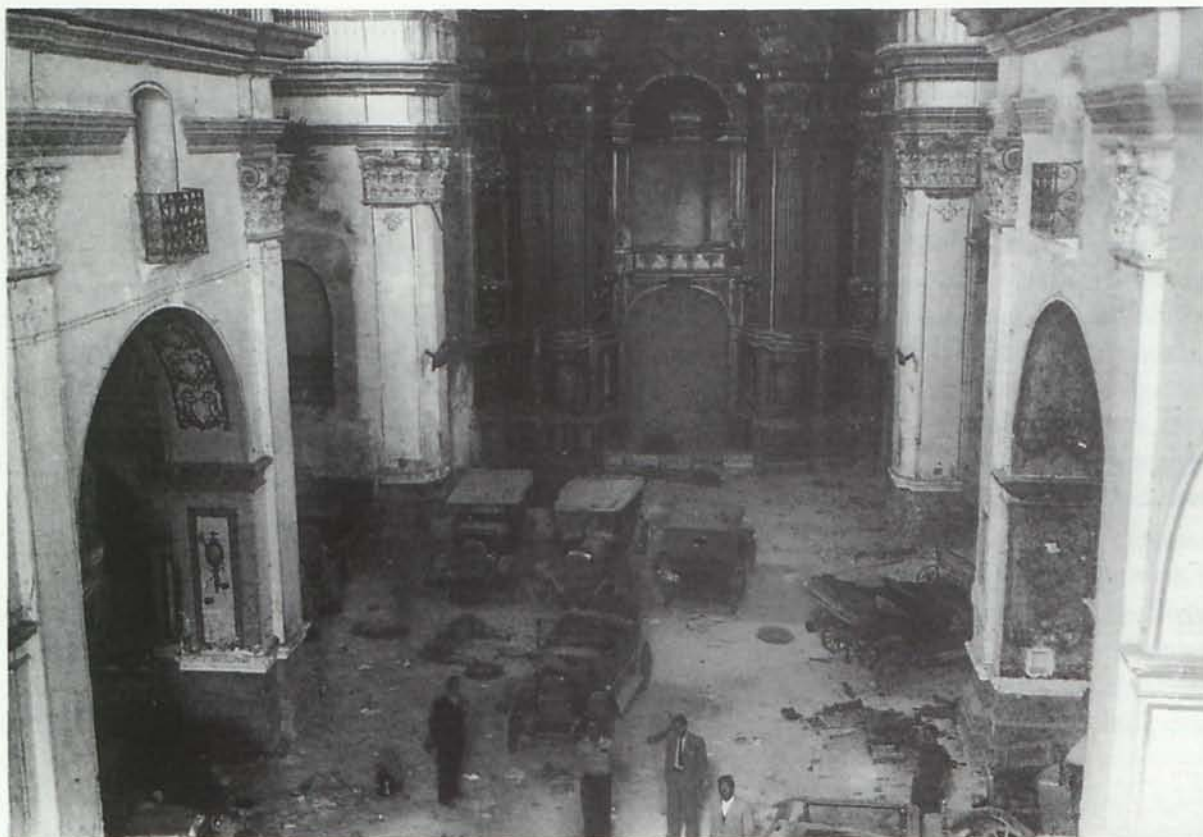
1. Al estallido de la contienda civil de 1936, la iglesia de Huércal-Overa, como sucediese en otras muchas localidades bajo control republicano, perdió sus atributos religiosos, destinándose sus espacios a otros menesteres. Obsérvese el estado de degradación del templo, entonces garaje de vehículos requisados. (Col. particular)
