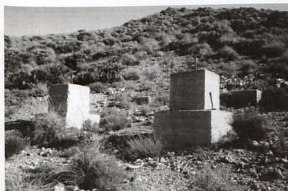
Figura 4. Bases de cemento sobre las que se anclaban las torres metálicas que sustentaban el cable aéreo.
