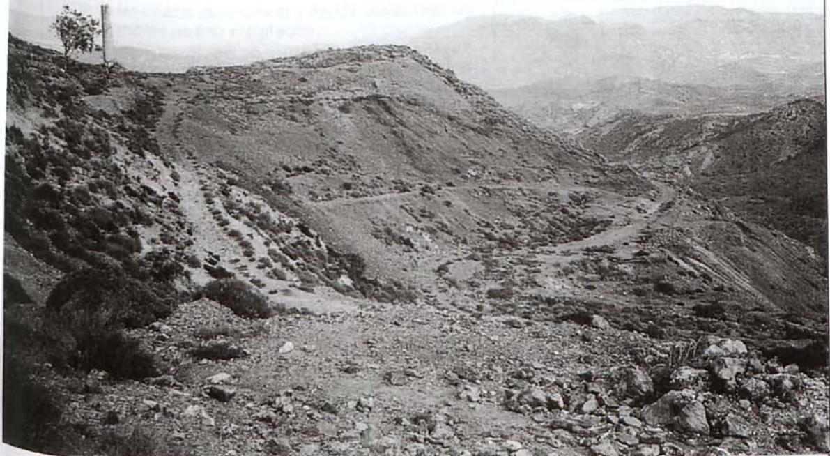
Figura 2. Dique de estériles de las instalaciones del siglo XIX de "Santa Bárbara" donde se puede apreciar el hueco dejado por las extracciones de mineral realizadas por TRAMISA.
