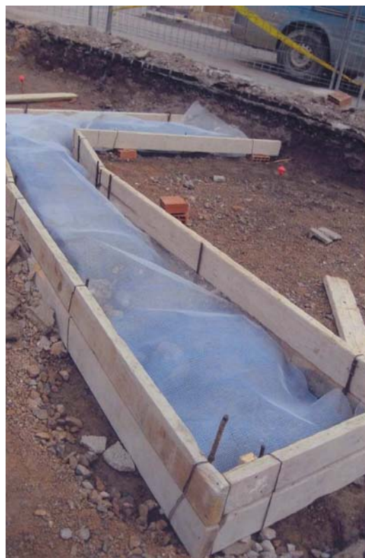
Lámina III. Momento de cubrimiento del muro con geotextil para su protección
