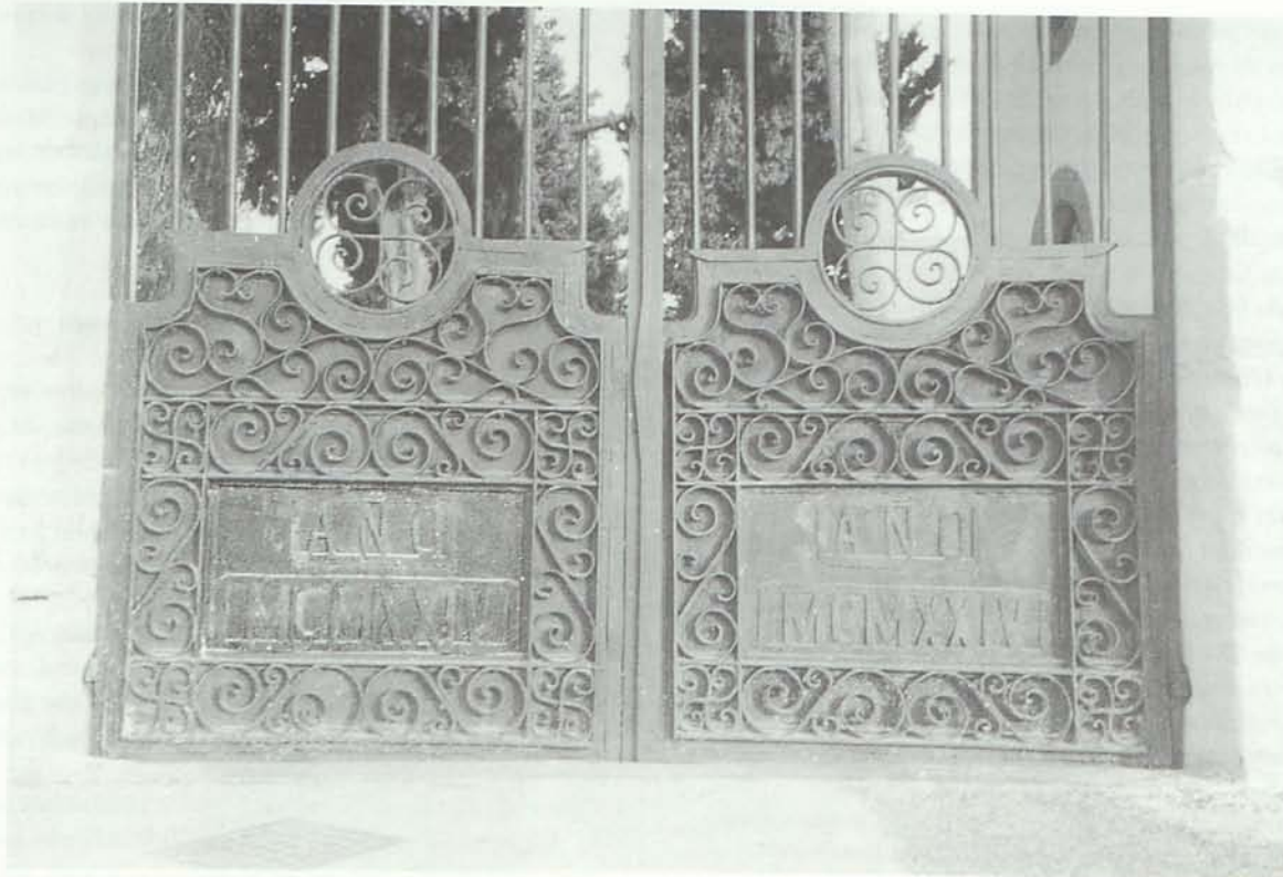
7. Parte baja de la verja en la que figura el año de finalización.
